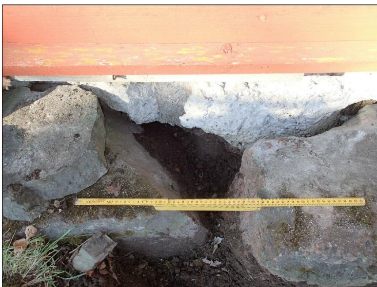
Alemmat (ja ulommat) perustuskivet sijaitsevat noin 40 cm syvyydellä rakennuksen puisesta alapohjasta. Betonivahvistus näkyy alkuperäisen kivijalan takana.
