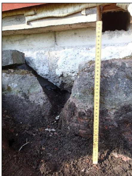
Alemmat (ja ulommat) perustuskivet sijaitsevat noin 40 cm syvyydellä rakennuksen puisesta alapohjasta. Betonivahvistus näkyy alkuperäisen kivijalan takana.
