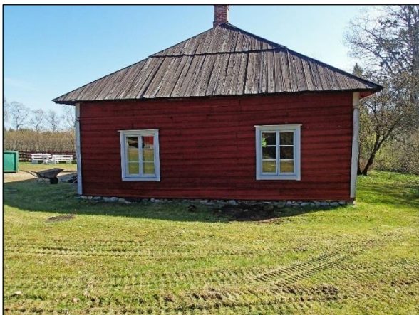
Tutkittu kohta rakennuksen perustaa sijaitsee oikeanpuoleisen ikkunan kohdalla.
