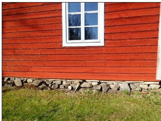
Alipytingin itäpää. Tutkittavaksi valittu paikka on rakennuksen ikkunan kohdalla.
